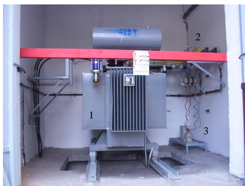
Слика 9.21: Положак кондензатора за компензацију реактивне снаге потребне за магнећење трансформатора
